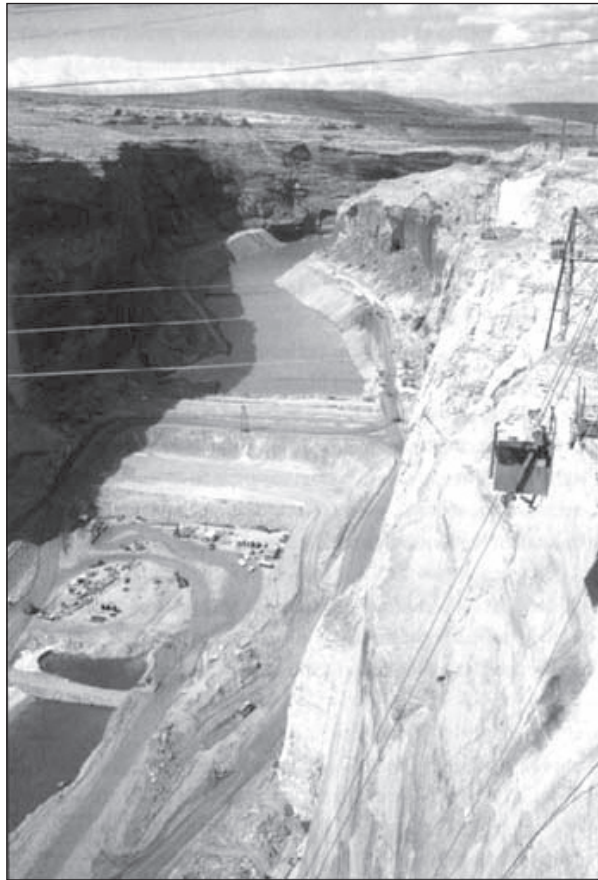
Figure 3 — Photographies du barrage du Glen Canyon en construction, le lac Powell à l'arrière
